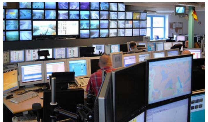
Bild 18 Verkehrsleitzentrale - moderne Technik, so wichtig wie Asphalt
