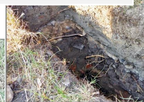
Abbildung 11: Blick in die Schachtung Nummer 1. Deutlich intensiv mit Feinwurzeln durchwachsene Schotterschicht her
